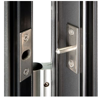
2 Bolzensicherungen im oberen und unteren Bereich verhindern das Aushebeln des Türflügels (Einbruchschutz)
